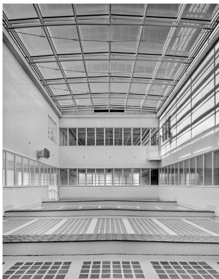
DALŠÍM TYPICKÝM ZNAKEM JSOU SKLOBETONOVÉ VÝPLNĚ MNOHA TYPŮ.
