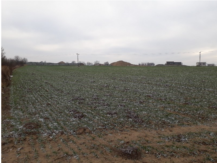
Pohled k jihu na započatou výstavbu rodinných domů
