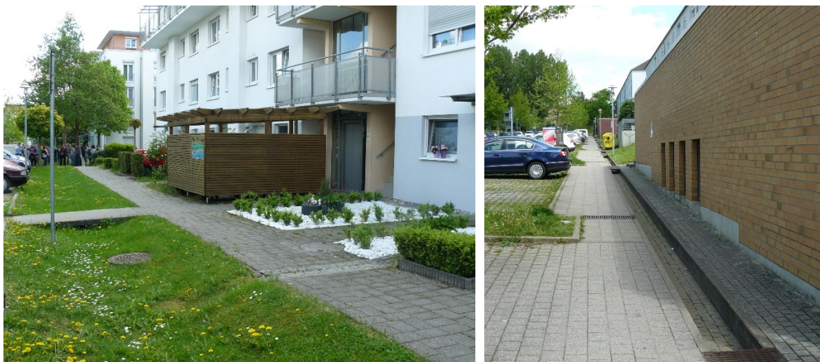
Řešení průlehu se svodem vod i ze střechy sousedního domu a povrchový kanálek dešťových vod, Ostfildern, Stuttgart Německo, Ramboll, 2004
