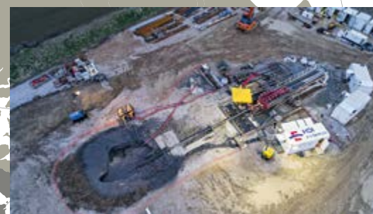
Plynovod Trans Adriatic Pipeline, Řecko
