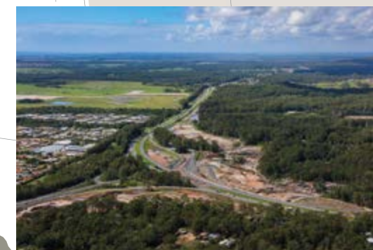
Stavba železniční trati na severu Brisbane, Austrálie
