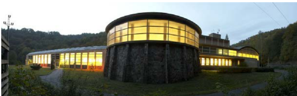
Úpravna vody Klíčava v podvečer
