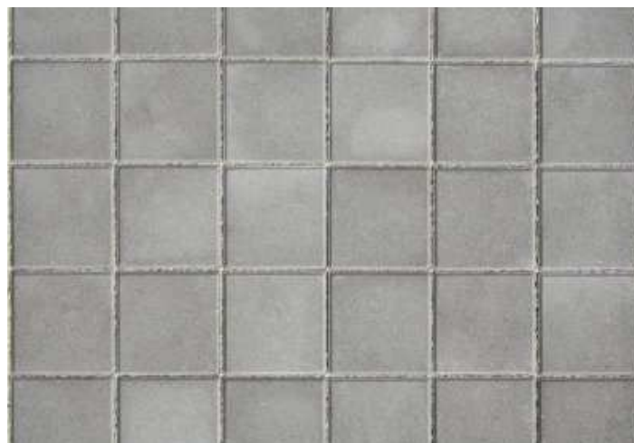
Pochozí plochy – chodníky v souběhu se silnicí – dlažba betonová šedá
