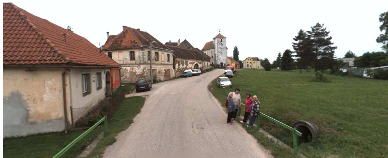
Úprava silnice II/409 – průtah místní části
