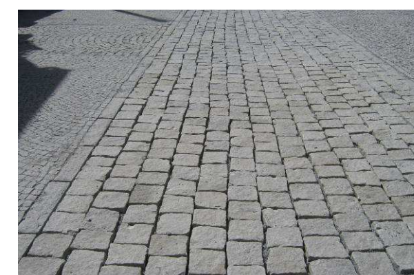
Příklady řešení kamenné dlažby – silnice II/409 - kamenné žulové kostky - variantně oblouková nebo řádková skladba
