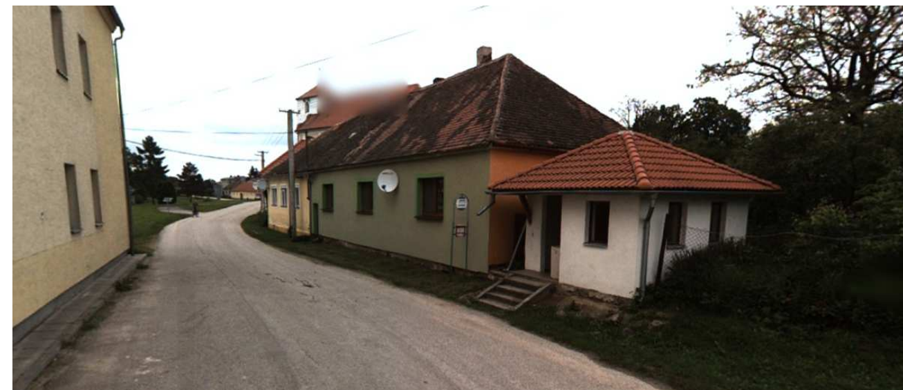
Autobusová zastávka v zúženém profilu silnice II/409 na východním okraji řešeného území
