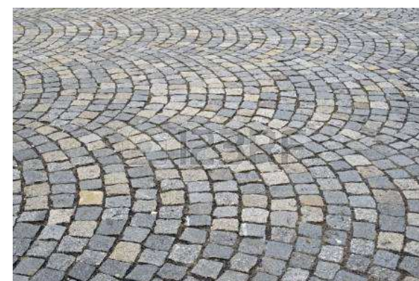
Příklady řešení kamenné dlažby – silnice II/409 - kamenné žulové kostky - variantně oblouková nebo řádková skladba
