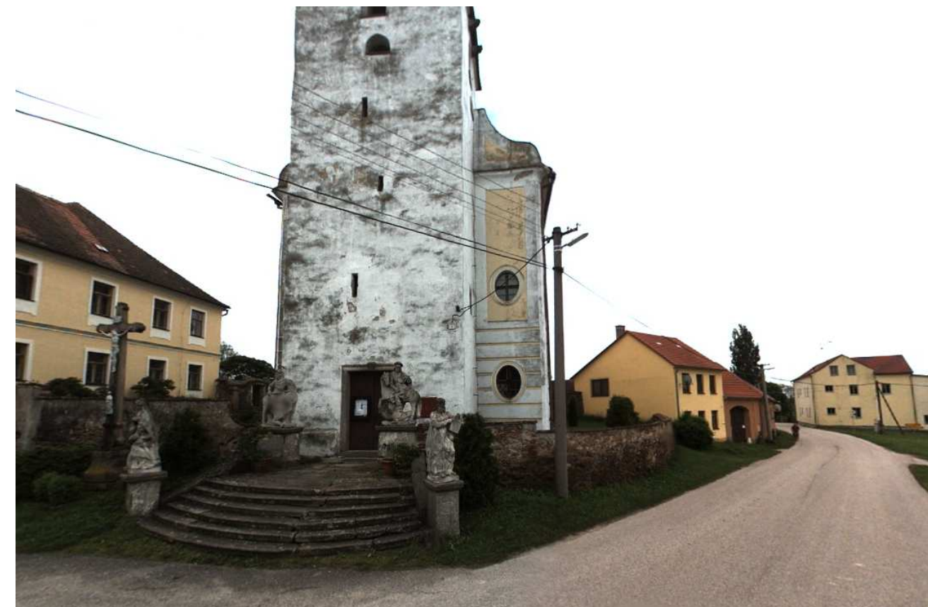
Nadzemní vedení NN, VO a SEK v těsné vazbě na památkově chráněný kostel
