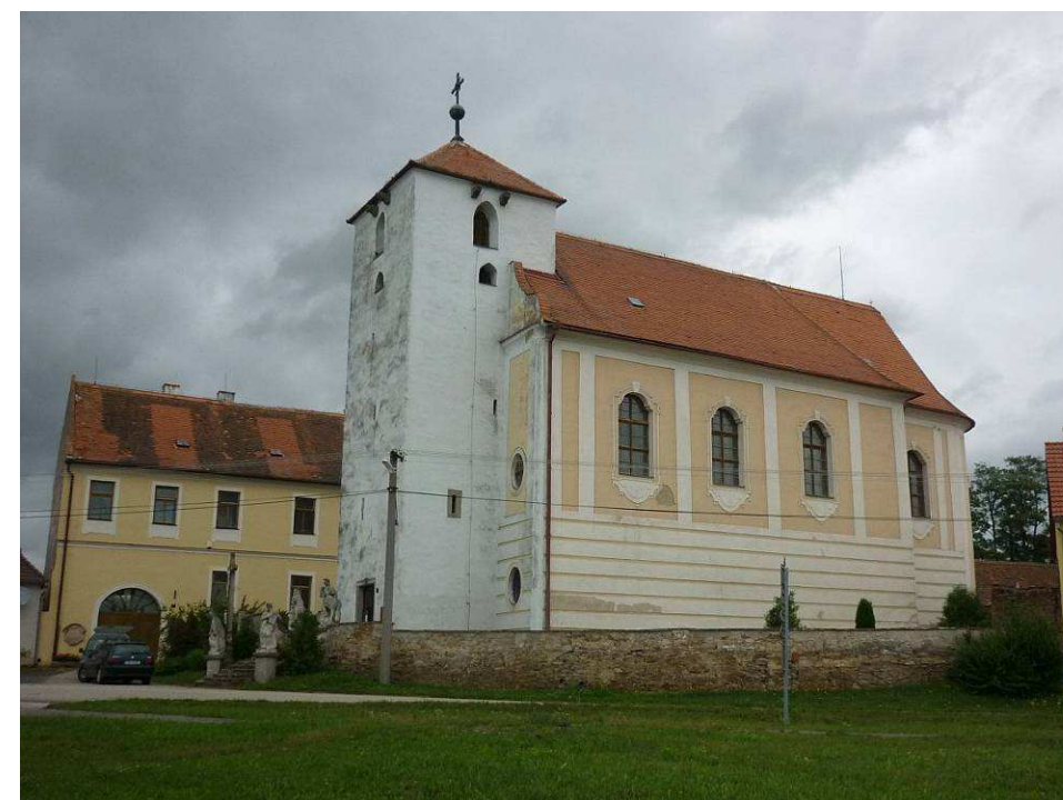
1. Kostel Nanebevzetí P. Marie, č. r. ÚSKP: 45370/3-2113, zaps. 3/5 1958, p.č. st. 51, k.ú. Rancířov Barokně vystavěný kostel na místě gotického opevněného kostela, z něhož zbyla hmotná hranolové věž z 15. století. Věž měla navíc původně dřevěný ochoz, ze kterého zbyly na stěnách krakorce. Na schodišti před kostelem jsou socha sv. Martina a sv. Jiřího na koních a sv. Anny a sv. Jáchyma z doby kolem roku 1765 zhotovené z eggenburského vápence.
