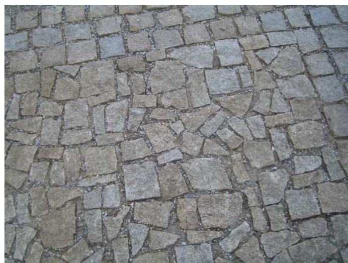
Pochozí plochy v prostoru „náměstíčka“ a mimo souběh se silnicí v zeleni, stejně jako nájezdy k nemovitostem a případná odstavná stání před nimi – kamenná dlažba štípaná nepravidelná (odseky)
