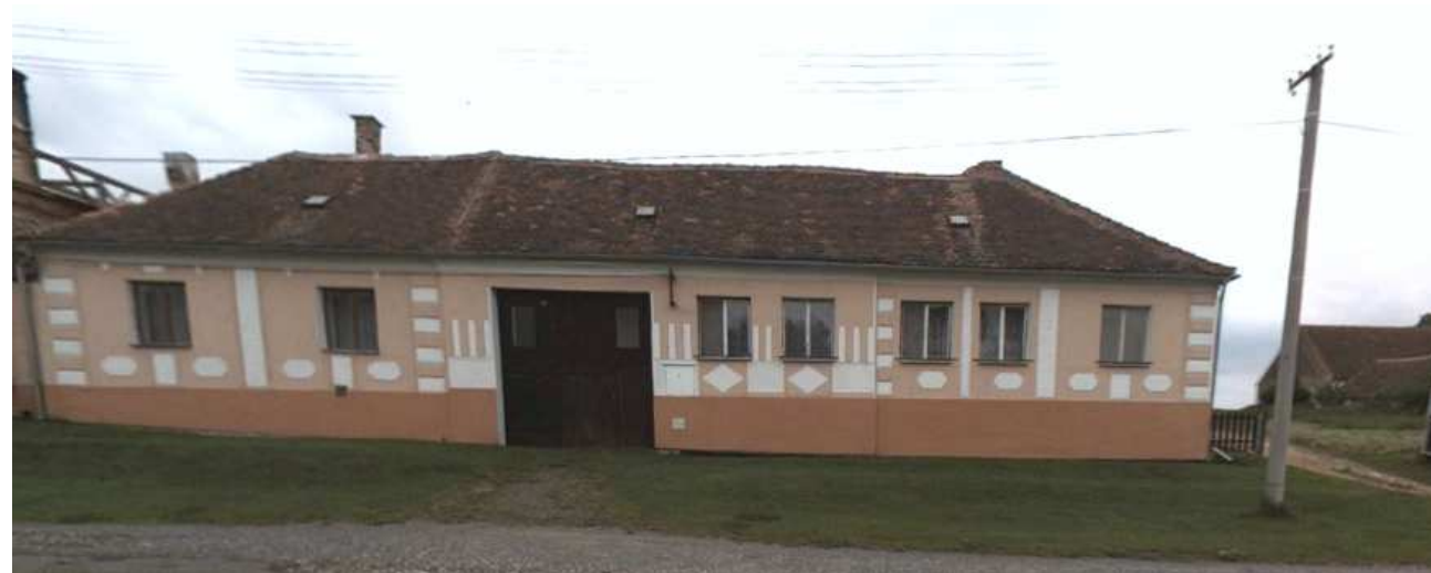
příklad nevhodné úpravy fasády - č.p. 15
