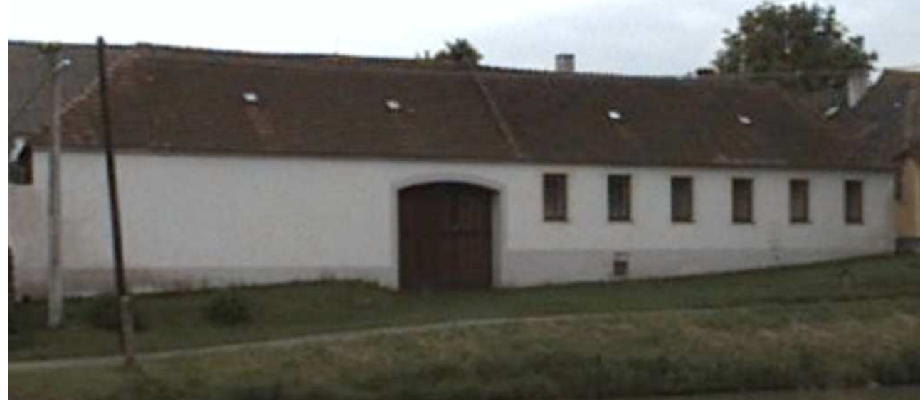
příklad nevhodné úpravy původní zástavby - č.p. 3 - po výměně oken - plast, zlatý dub, bez členění
