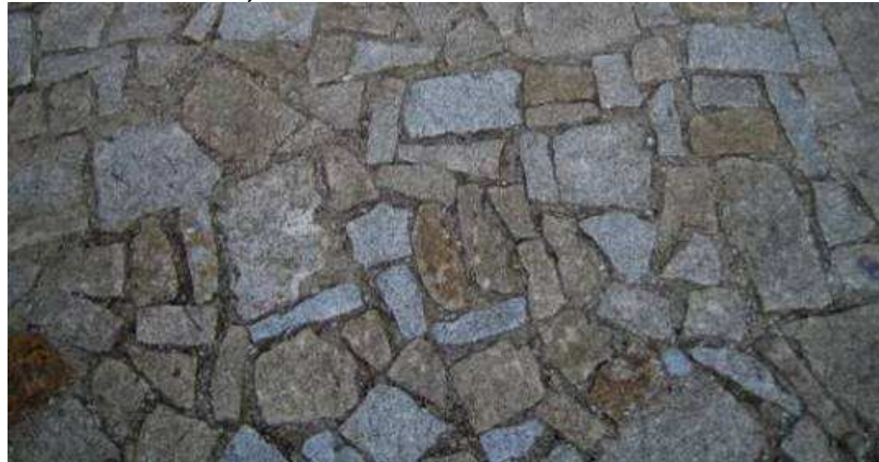
Pochozí plochy před kaplí a v prostoru původní stavby "likusáku" - velkoformátová žulová dlažba (odseky)
