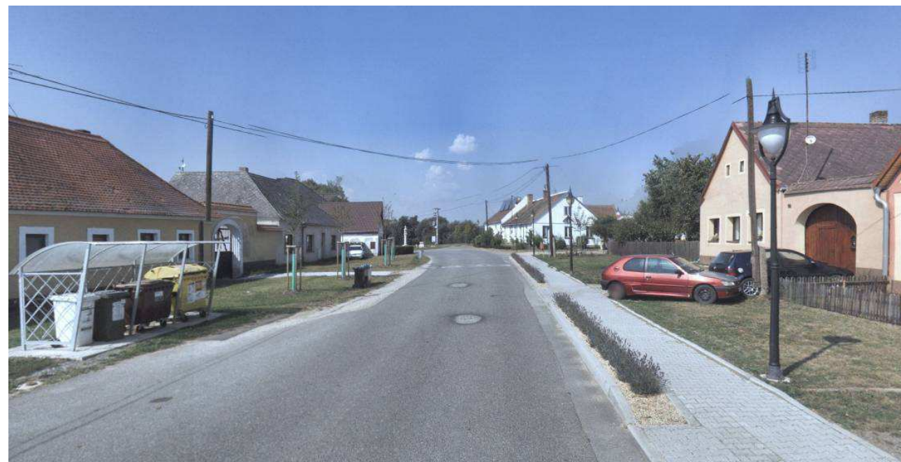
Vzdušné trasy sítě elektronických komunikací
