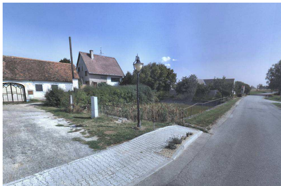
požární nádrž - stav
