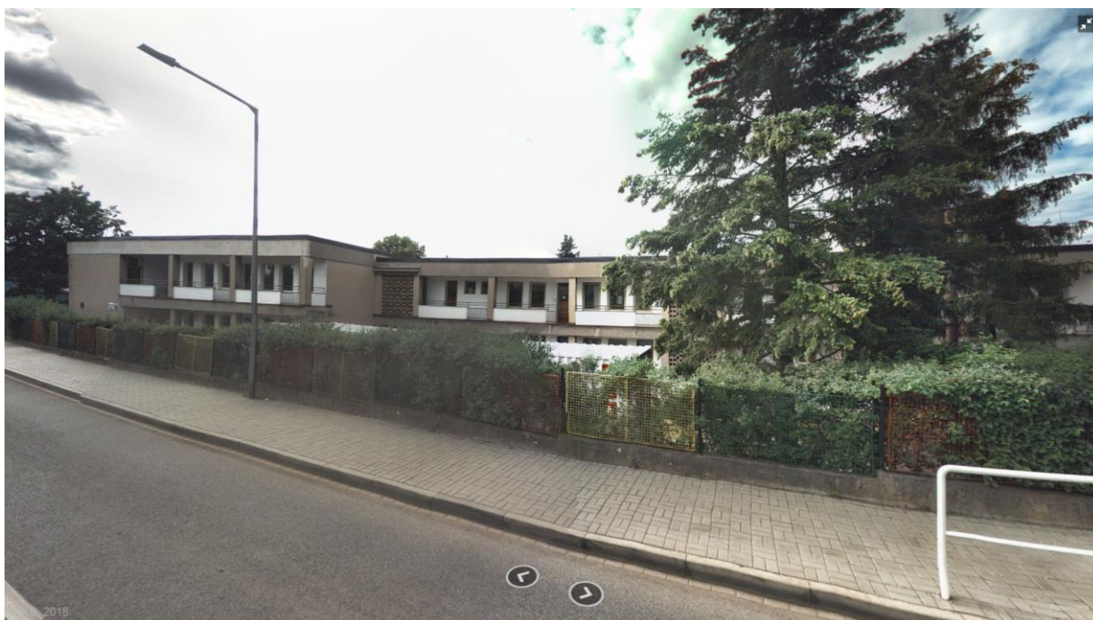
Fotografie mateřské školy z 06/2018 – stav před rekonstrukcí
