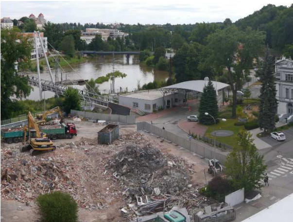
Pohled na parter během stavby
