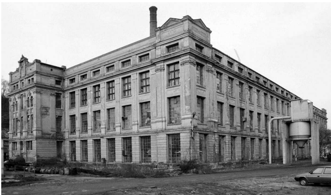
Fotografie původní zástavby a její architektonické formy
