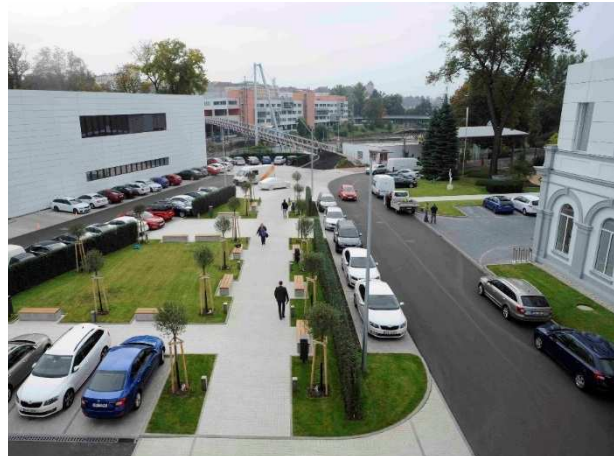
Pohled na parter po ukončení stavby
