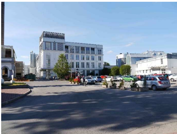
Pohled na parter před zahájením stavby
