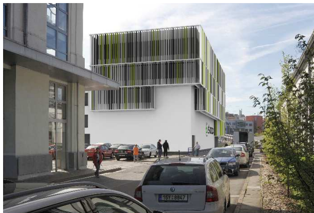
Kondiční prostor DPS - Hlaváček-architekti
