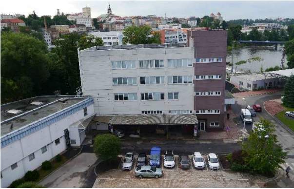
Pohled na parter před zahájením stavby
