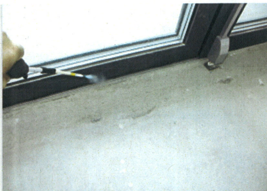
Netěsné spojení dvou křídel pomocného ► havar. vstupu 1NP
