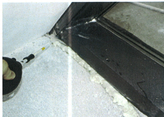
Netěsná připojovací spára rozsáhlého rohového ► zasklení (sekretariát 2NP, recepce 1NP)
