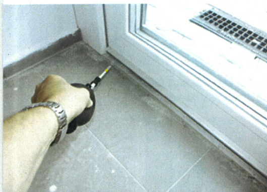
Netěsné spojení dvou křídel pomocného ► havar. vstupu 1NP
