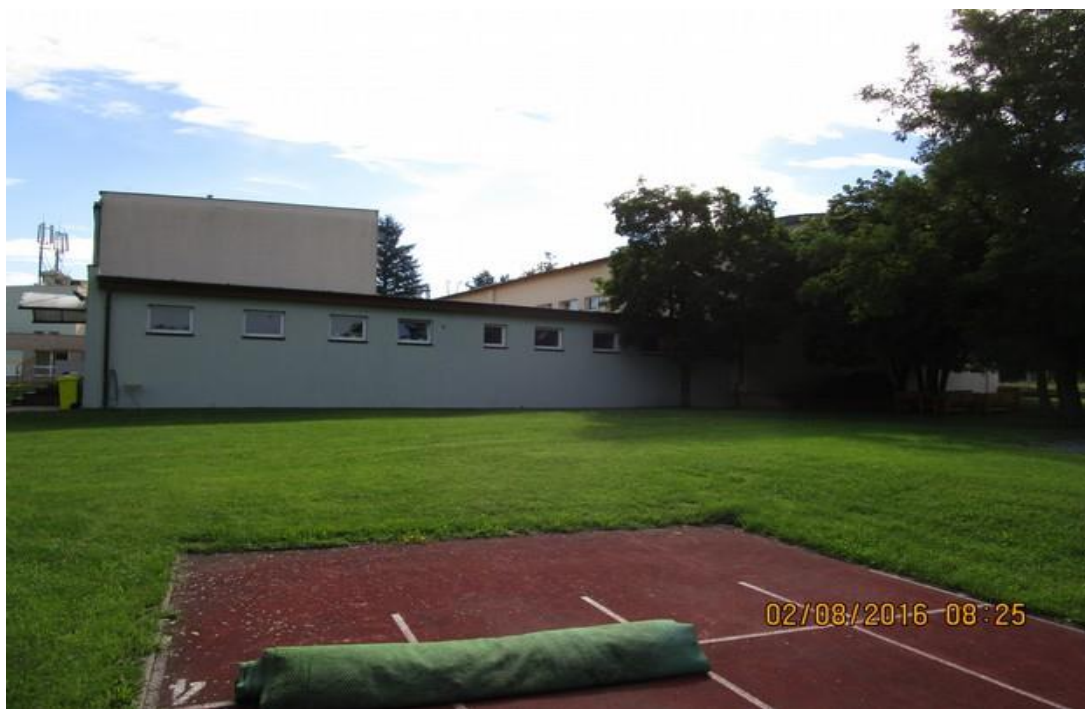
Původní stav: pohled na původní šatnový blok, tělocvičnu a štít pavilonu ZŠ (cca z prostoru nové haly)
